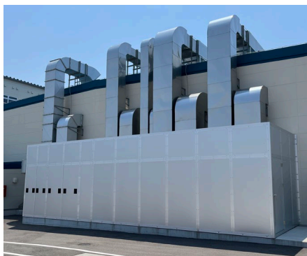
ボイラー防音壁の設置（第3工場）
