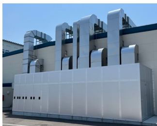
ボイラー防音壁の設置 (第3工場)
