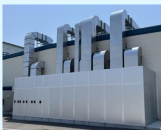
排気ファン防音壁の設置 (第3工場)
